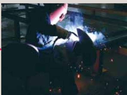
▲ 拡翼取付溶接
