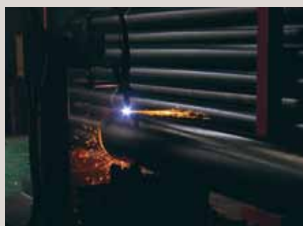
▲ 拡翼取付部自動切断中
