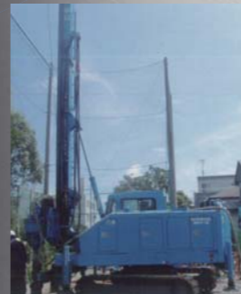
クローラー式杭打ち機
