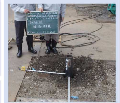
打設完了(偏芯確認)
