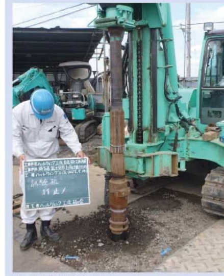
打設完了(打ち止め)
