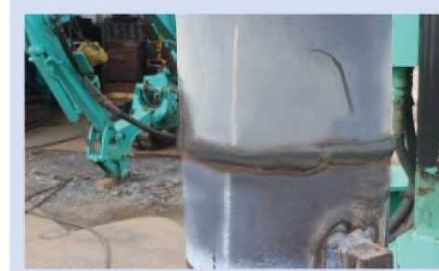
継手溶接完了
