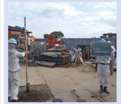
打設完了(レベル確認)
